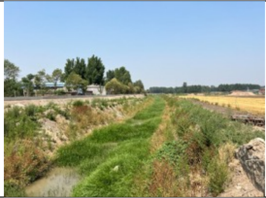
修武县山门河现状
