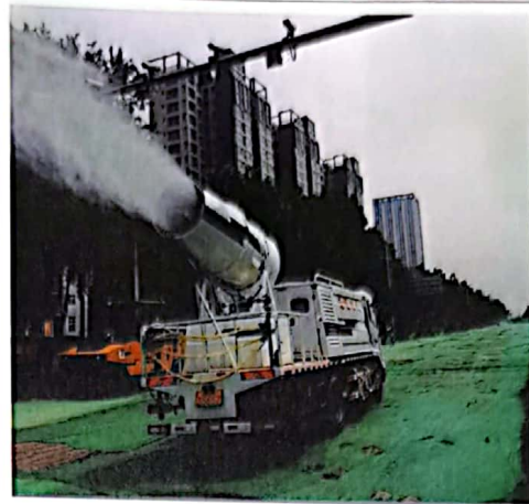
人民路施工路面洒水降尘及防尘网苫盖
