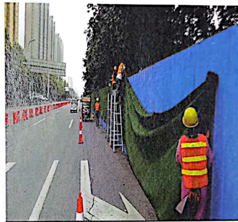
人民路施工作业区围挡
