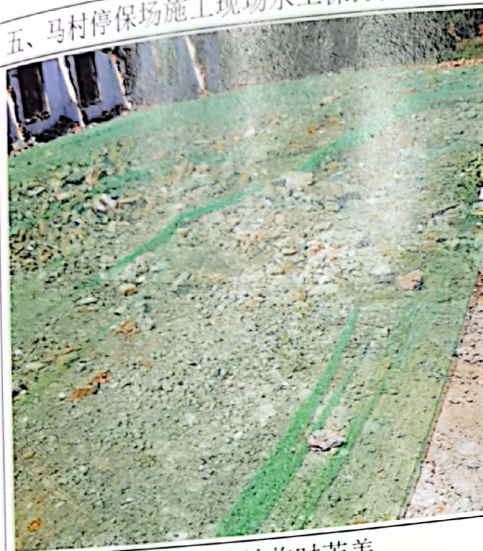
建筑物拆除迹地临时苦盖
