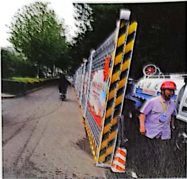
塔南路施工作业区拦挡
