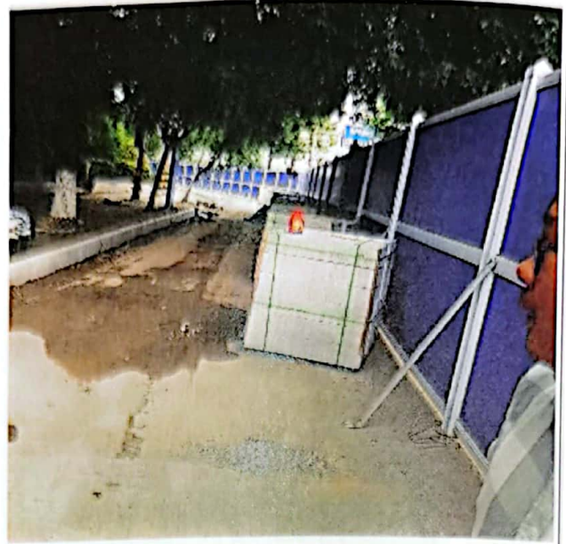
塔南路施工作业区拦挡
