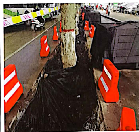
站前路南侧开挖面防尘网苫盖
