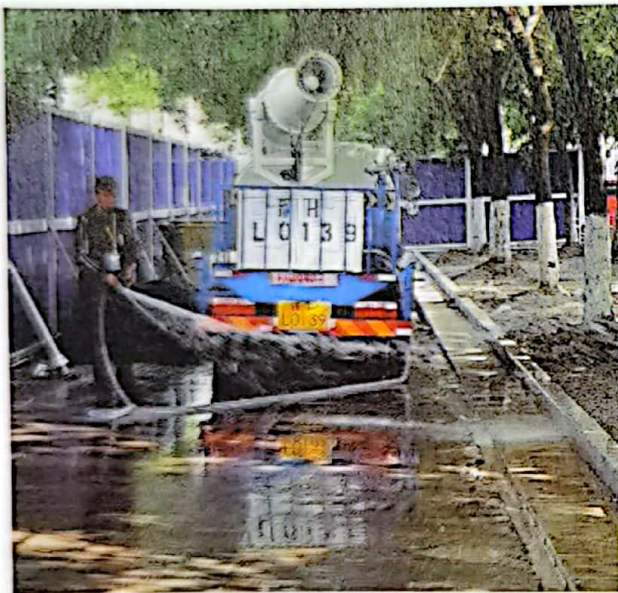
塔南路施工作业区洒水降尘
