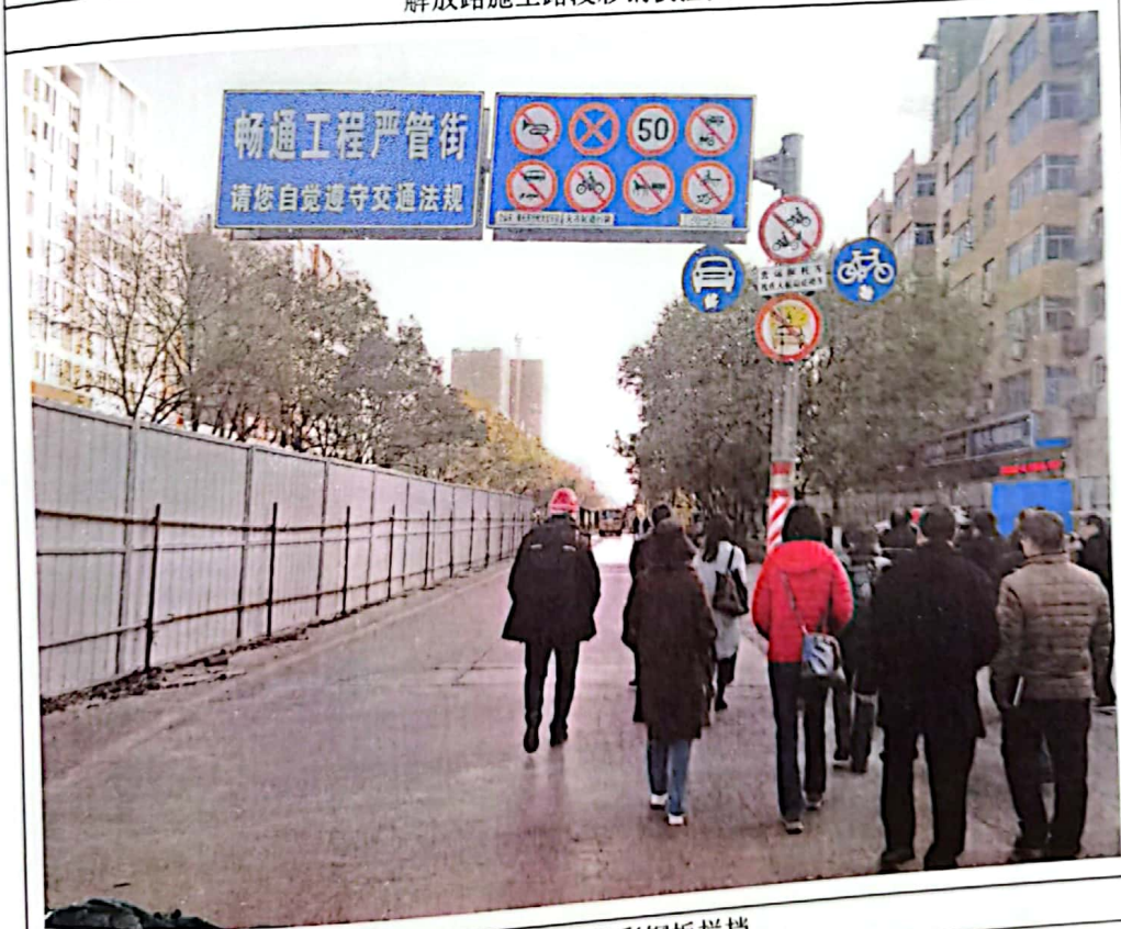
解放路施工路段彩钢板围挡
