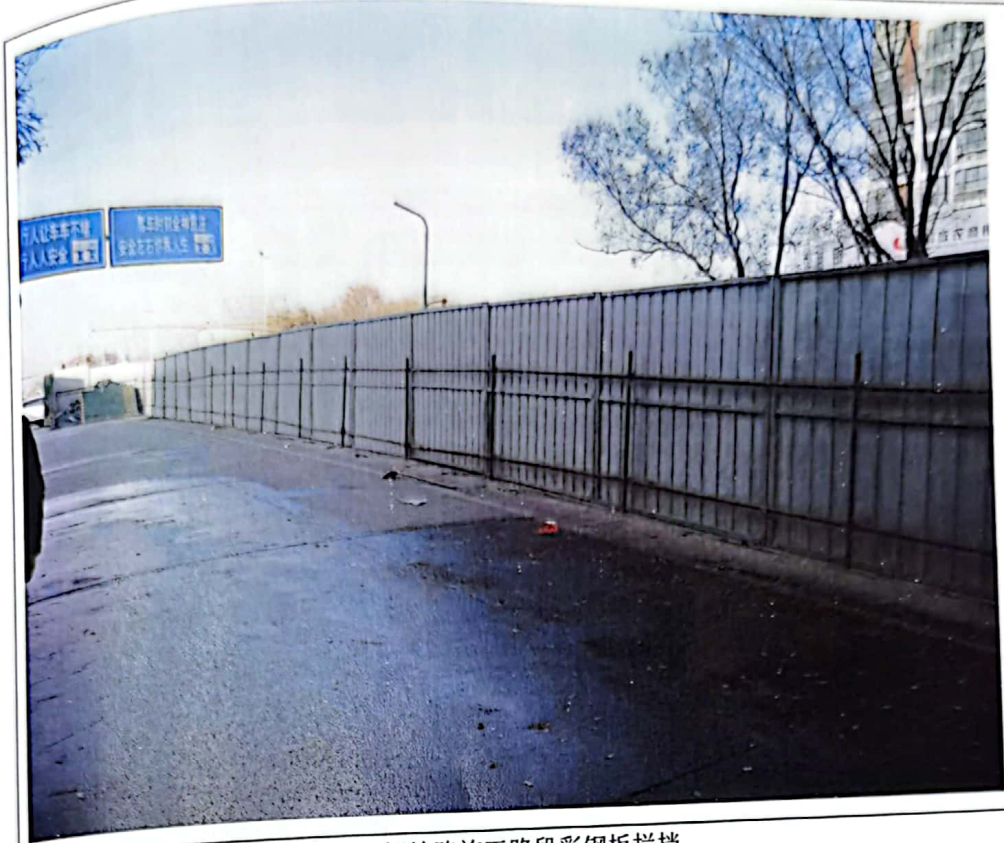
解放路施工路段彩钢板围挡
