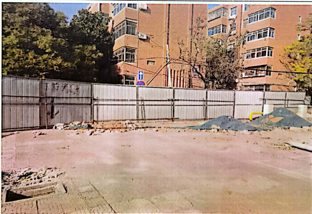
施工区域临时拦挡
