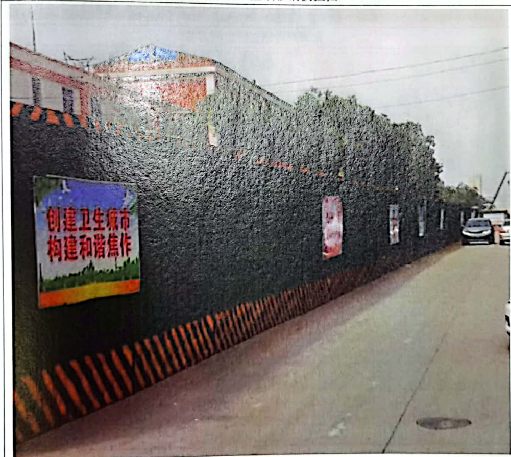
解放路施工区域彩钢板围挡
