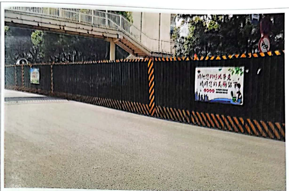
解放路施工区域彩钢板围挡
