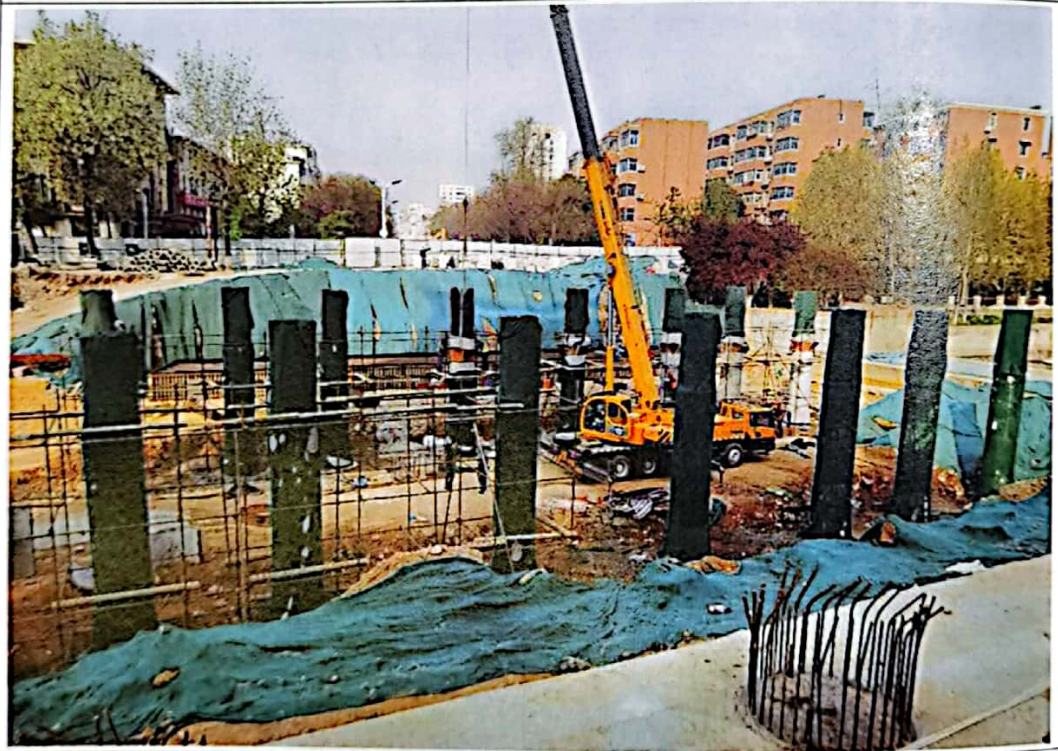
群英河桥施工防尘网苫盖
