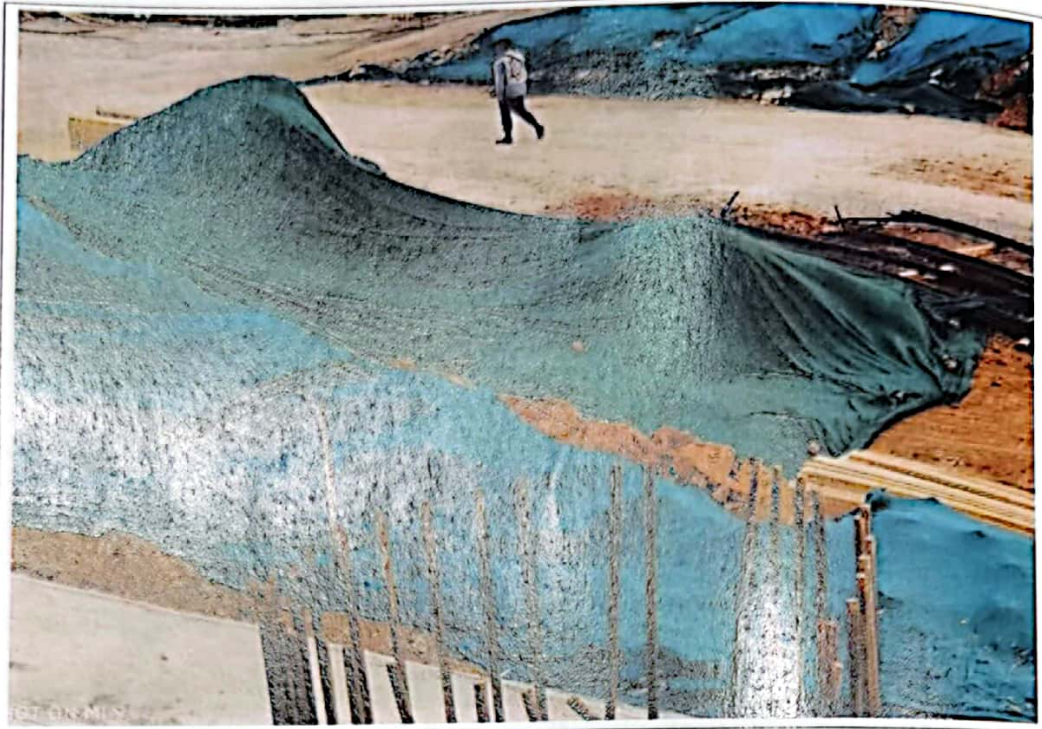
瓮洞河桥施工防尘网苫盖
